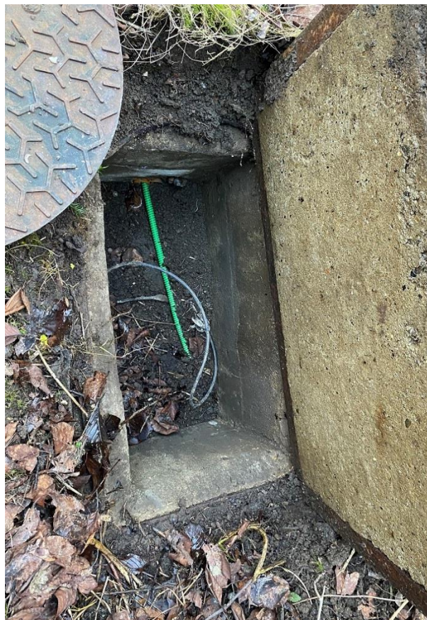
Photo 19- RV Eaux Pluviales P=1,03m
