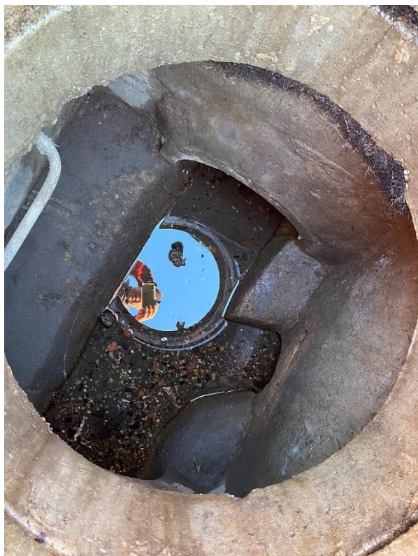
Photo 14-Séparateur d'hydrocarbures (?)
