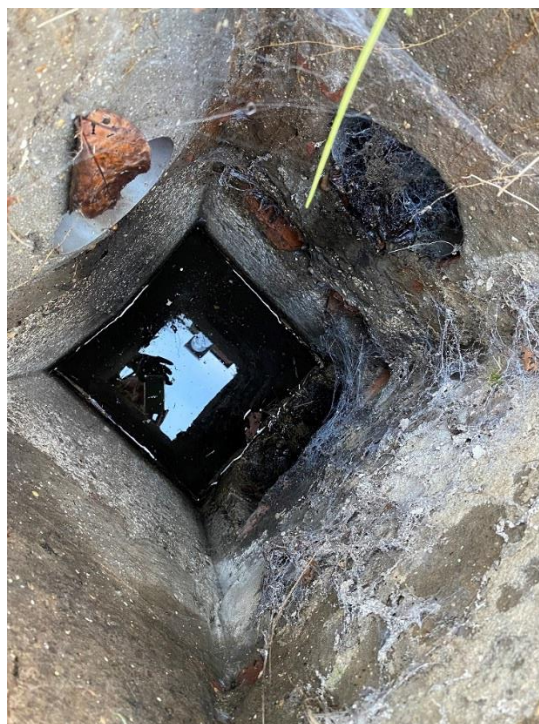
Photo 19- RV Eaux Pluviales P=1,03m
