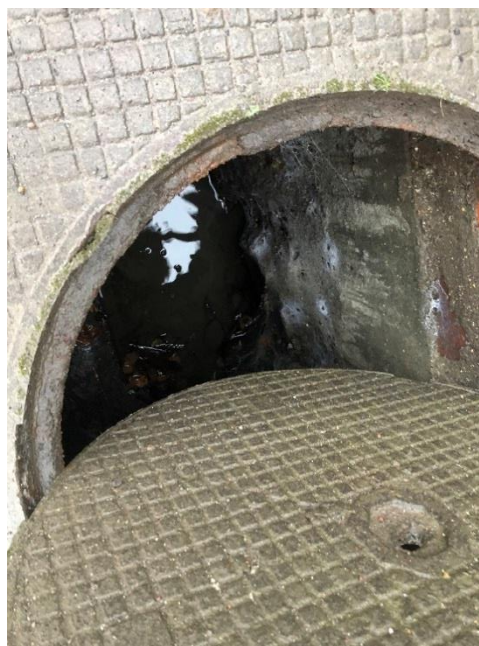
Regard de visite sur Réseau Eaux Pluviales DN400
